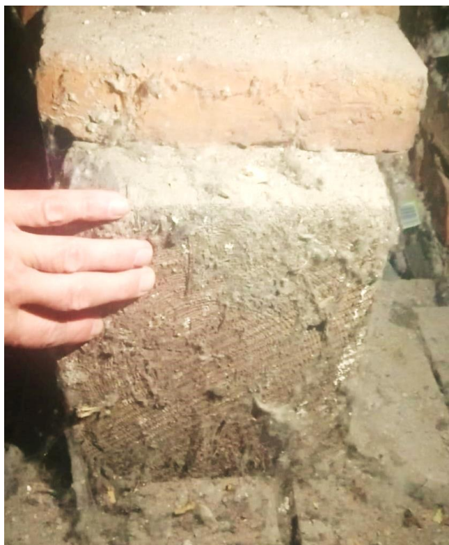
Podwalina stupa wiezby poddasza
